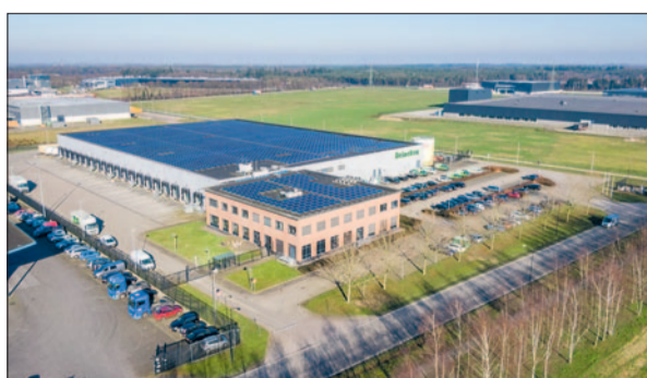
TH WAREHOUSE MET KANTOORRUIMTE VORSTENGRAFDONK 63, 055
