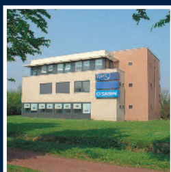
TH | Luxe kantooretage op de 1e verdieping Bolwerk 12 • Veldhoven
