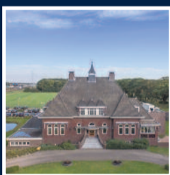
TH | Kantoorvilla Eindhovenseweg 128 te Waalre
