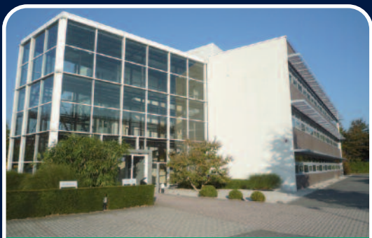
TH \ KANTOORRUIMTE SCIENCE PARK EINDHOVEN 5709 IN SON
