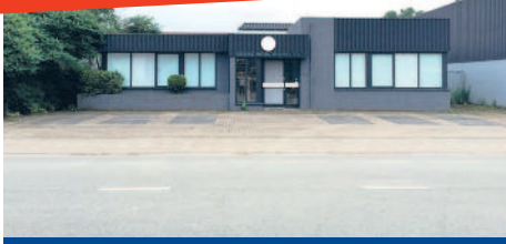
BEDRIJFSHAL EN KANTOREN
