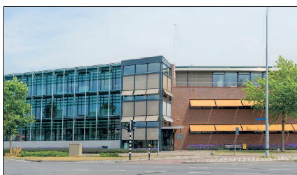
TH KANTOORETAGE OP ZICHTLOCATIE INSULINDELAAN 115, EINDHOVEN
