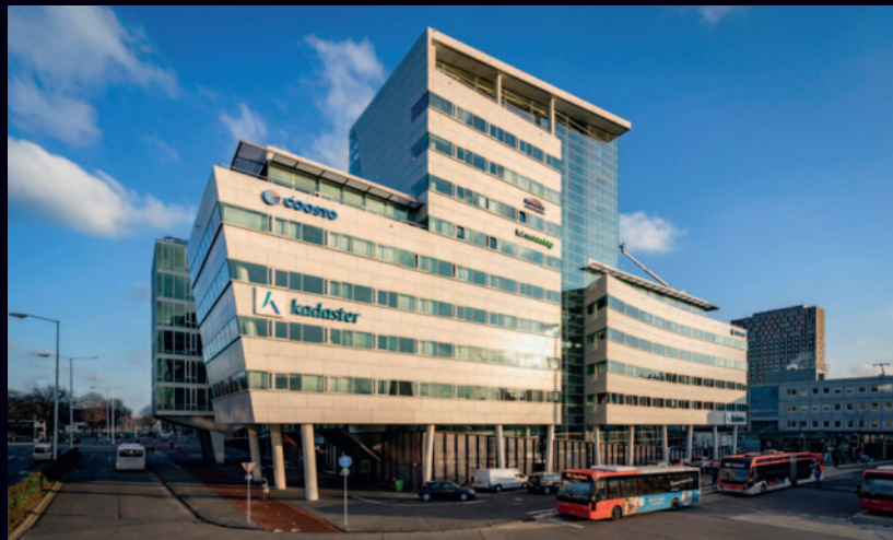
Turn-key project kantoor Brink Groep Eindhoven
