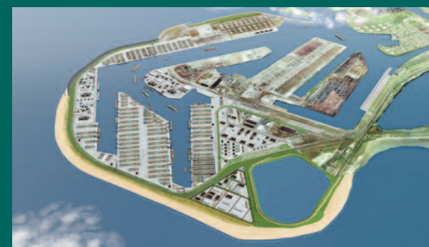
TH WAREHOUSES OP TOPLOCATIE MAKASSARSTRAAT 1 TE ROTTERDAM MAASVLAKTE
