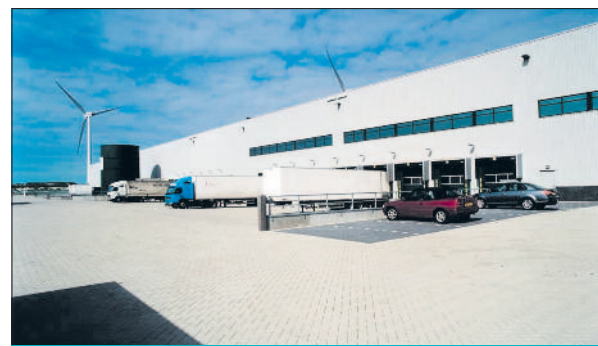
TH | PROLOGIS PARK MAASVLAKTE HAINANSTRAAT 1 ROTTERDAM
