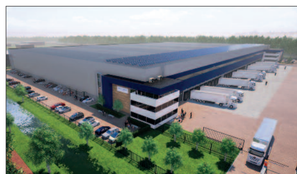
TH DCAM MOERDIJK MIDDENWEG 10 - HAVEN VAN MOERDIJK
