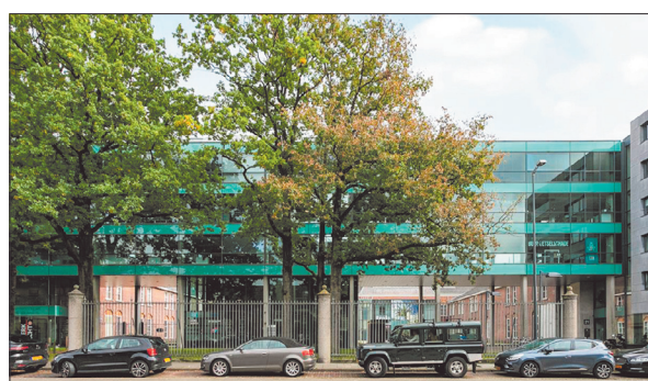
TH KANTOORUNIT IN COMPLEX 'MUSEUM KANTOREN' KEIZERSTRAAT 13, BREDA
