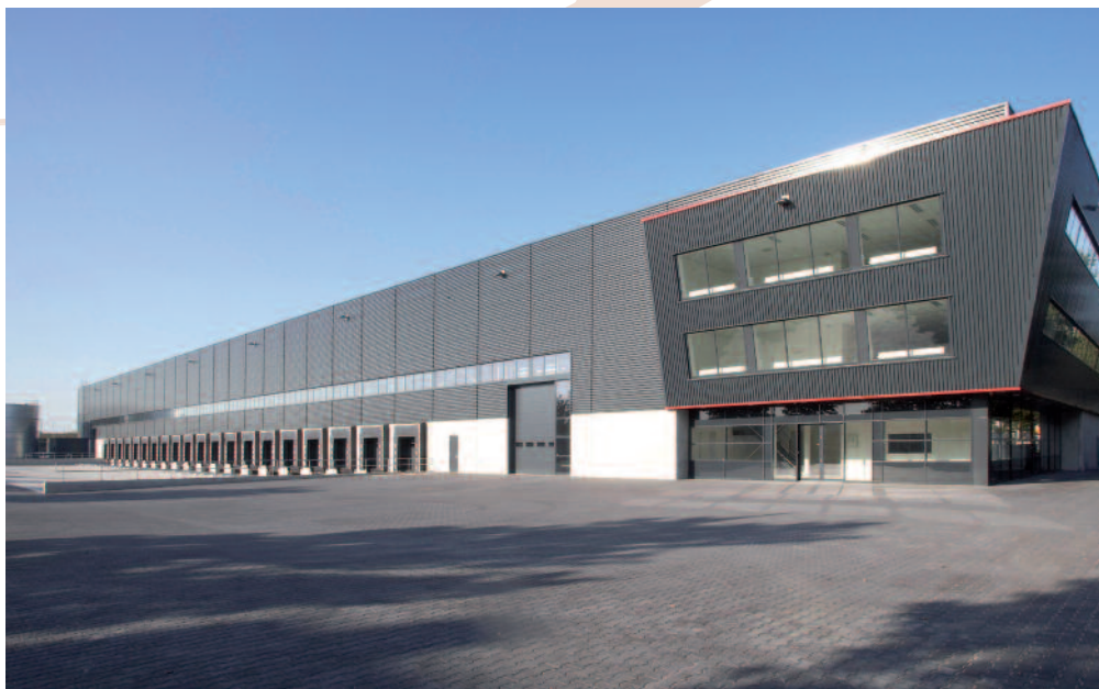
DC Posthorn, Grootvenstraat 14-16 Tilburg
