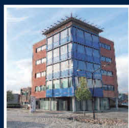
TH | Bedrijfsobject op zichtlocatie Biesbosweg 16 te Waalwijk
