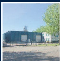
TH | TK Bedrijfscomplex Koopvaardijweg 54 te Oosterhout
