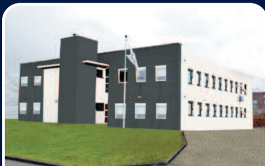
TH \ TK REPRESENTATIEF KANTOORGEBOUW CHARLES STULEMEIJERWEG 17-19 IN TILBURG
