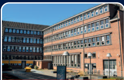
TH \ KANTOORRUIMTE POSTSTRAAT 68 TE TILBURG
