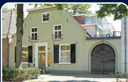
TH \ KANTOORRUIMTE DE LIND 40 TE OISTERWIJK
