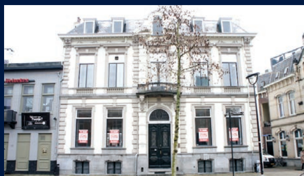
TK-TH KARAKTERISTIEKE KANTOORVILLA HEUVELRING 100 TILBURG
