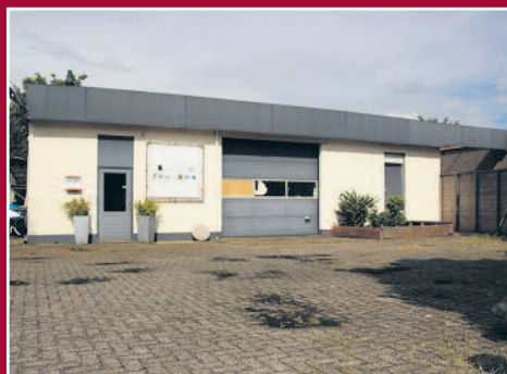
Dostalstraat 50a Tilburg
