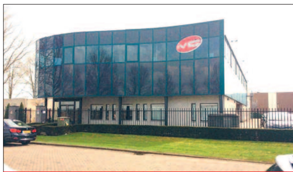
TH MODERNE BEDRIJFSRUIMTE MET KANTOREN INDUSTRIEWEG 32 WAALWIJK
