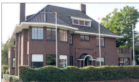
NIEUW KANTOOR BRESSON VAN KEMPEN BEDRIJFSHUISVESTING TIVOLISTRAAT 2 TILBURG
