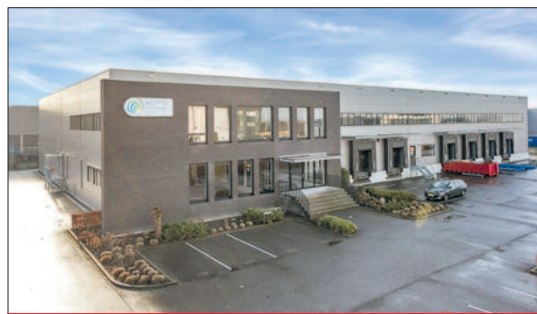
TH-TK BEDRIJVENCOMPLEX VAN SCHIJNDELSTRAAT 7, WAALWIJK
