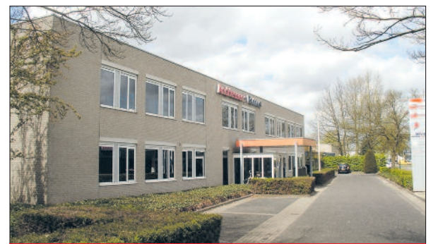
TH REPRESENTATIEVE KANTOORRUIMTE AMBACHTSTRAAT 19, OISTERWIJK
