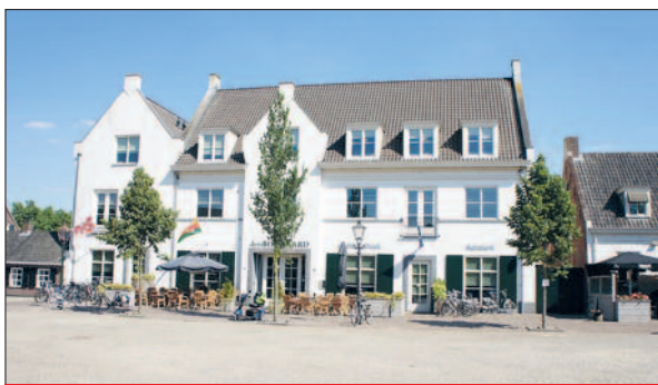
TH ZELFSTANDIGE KANTOORVERDIEPING SINT JANSPLEIN 5, MOERGESTEL
