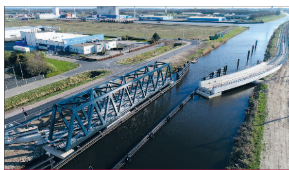
NIEUWE BEWEEGBARE SPOORBRUG OVER HET KANAAL COEVORDEN-ALMELO
