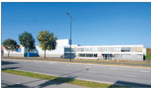
TK 3 GESCHAKELDE BEDRIJFSHALLEN MET KANTOORRUIMTE LAAN VAN MALKENSCHOTEN 95 APELDOORN
