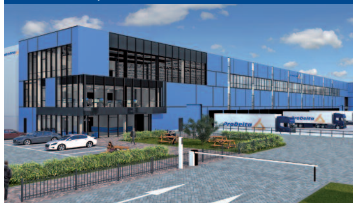
De Riemsdijk 1/Grotewei, Tiel
