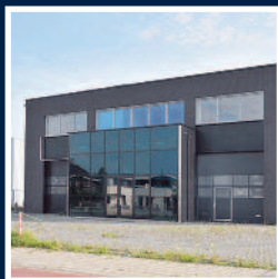
TK | Bedrijfsverzamelgebouw Ambachtenlaan 23 Etten-Leur
