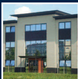
TH | Bedrijfsruimte Van de Reijtsstraat 49 (ged.) Breda
