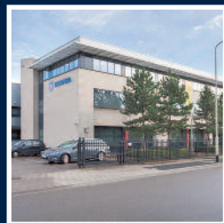
TH | Kantoorruimte Grenssteen 35 Breda
