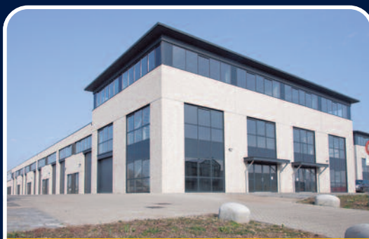
TH-TK \ BEDRIJFSHALLEN MET KANTOOR VAARTWEG 8-12 TE OOSTERHOUT
