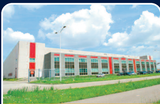
TH \ DISTRIBUTIECOMPLEX TRADEBOULEVARD 7 TE MOERDIJK
