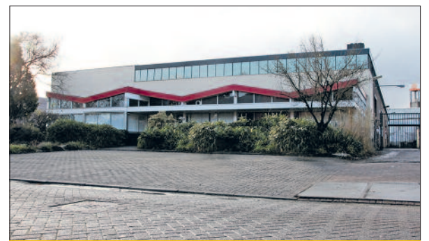
TK VOORMALIGE ZOETWARENFABRIEK HAVENWEG 35, OOSTERHOUT
