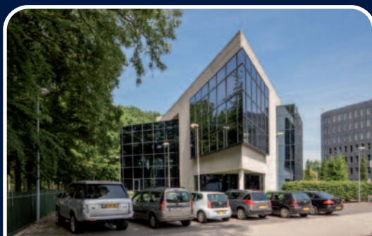
TH \ KANTOORRUIMTE PARMENTIERWEG 14 TE EINDHOVEN
