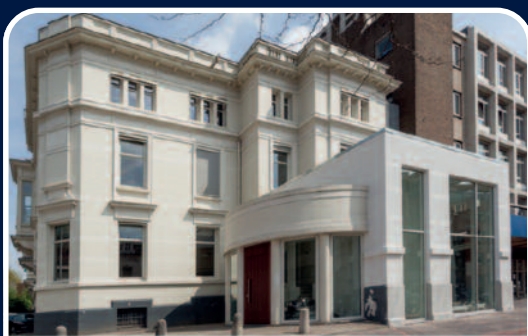
TH \ KANTOORVILLA VESTDIJK 23 TE EINDHOVEN
