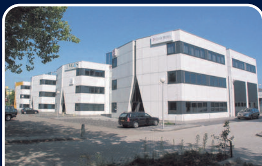
TH \ KANTOORRUIMTE DILLENBURGSTRAAT 5-7 TE EINDHOVEN
