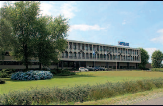
VB vastgoedinrichter 'bouwt' mee aan het nieuwe kantoor van HERAS te Oirschot.
