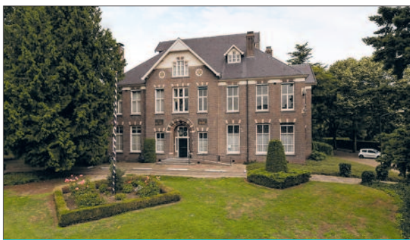
TH KANTOORRUIMTE IN RIJKS MONUMENTAAL PAND BURG. DE KUIJPERLAAN 1 TE VEGHEL
