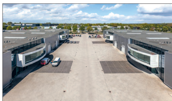
TH BEDRIJFSRUIMTE MET KANTOREN (3 UNITS) VOSSENBEEMD 109 B/C/D, HELMOND
